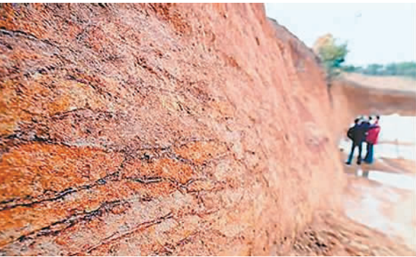
良渚古城水利系统堤坝关键部位以“草裹泥”工艺堆垒加固 新华社记者 王定昶摄
