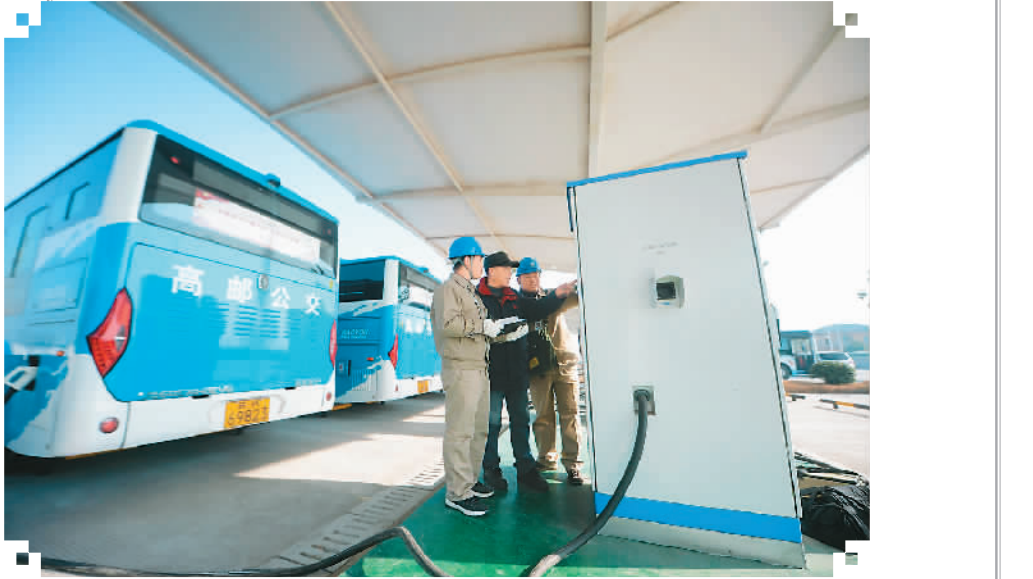
2017年12月22日，江苏省扬州市最大电动公交车充电站在高邮淮北路公交首末站投入使用。此座充电站共有19台充电桩，每台充电桩分别配备A、B两把充电枪。
