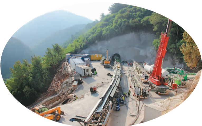
中国中铁自主研发的全断面隧道掘进机在黎巴嫩大贝鲁特供水项目工地上作业。 中铁装备供图
