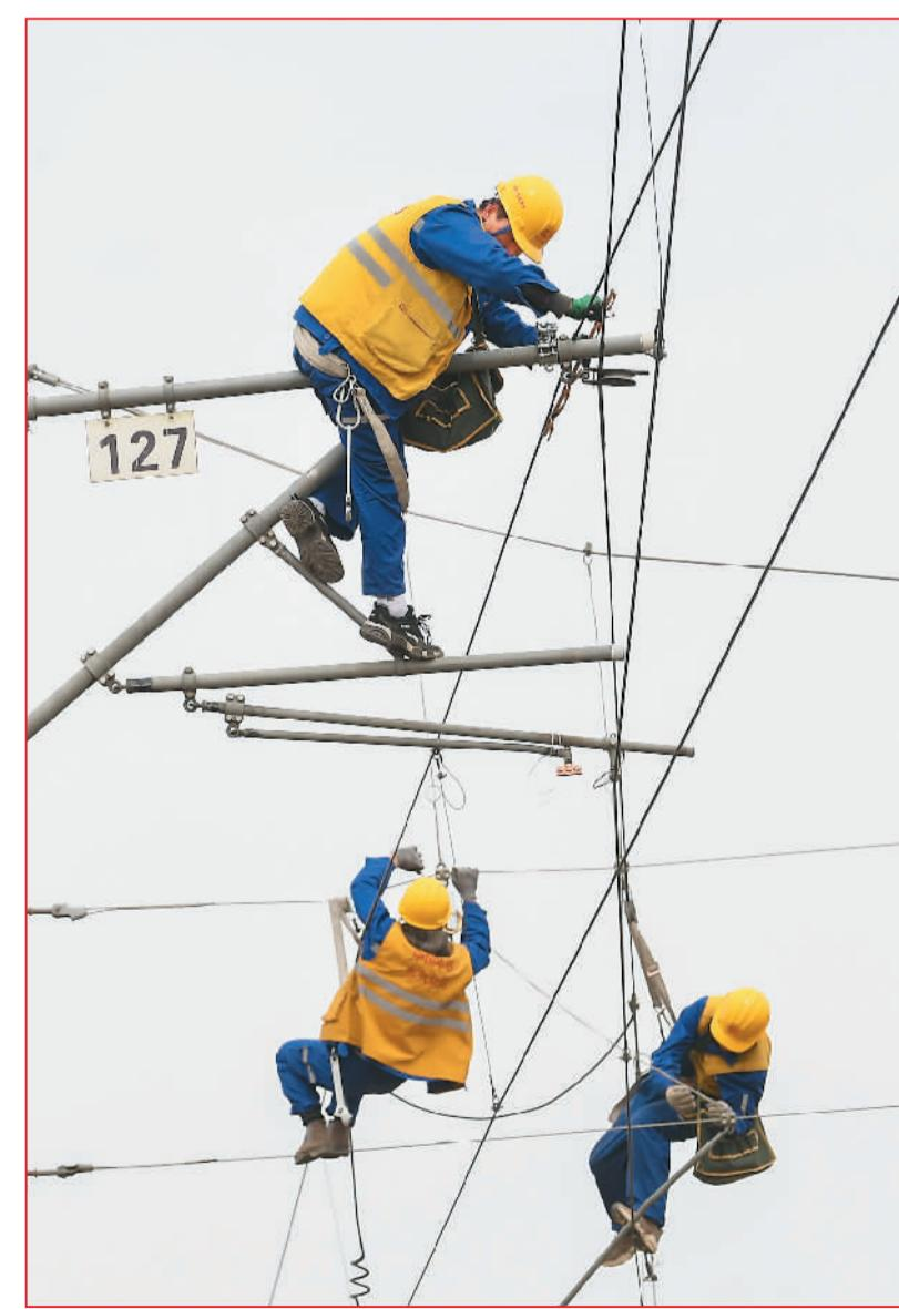
近日，为调整运输结构，增加铁路运输量，连接曹妃甸港和呼和浩特的唐呼线张集段正在进行万吨供电扩能改造工程。改造完工后，唐呼线将实现全年运量上亿吨的目标。唐呼线是中国西煤东运的重要通道之一。图为3月19日，工人们在唐呼线张集段古营盘站场进行线网改造。
