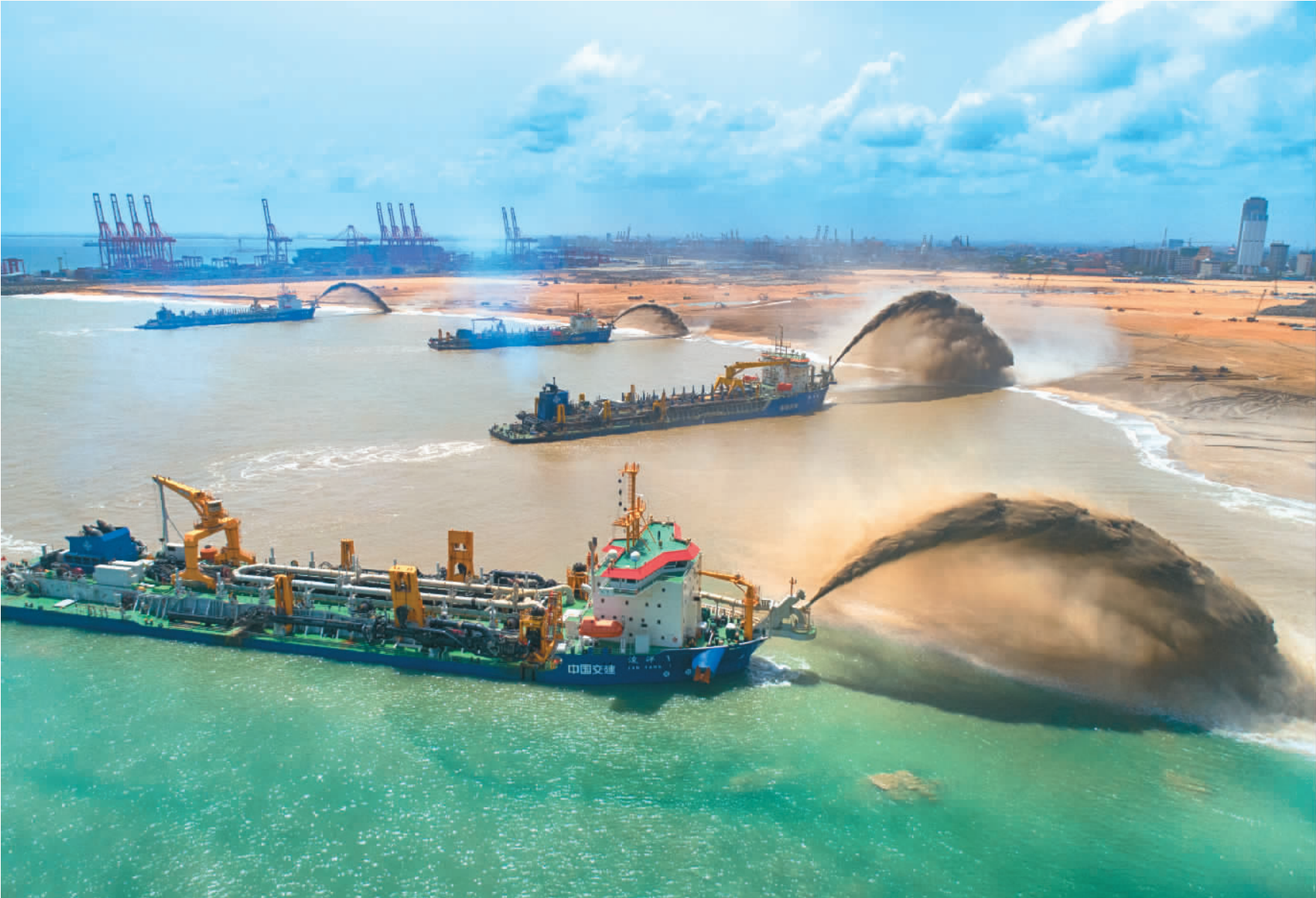
图为二〇一八年六月二十日，在斯里兰卡科伦坡，港口城项目工地上来自中国的企业大型耙吸挖泥船同时在吹沙。
