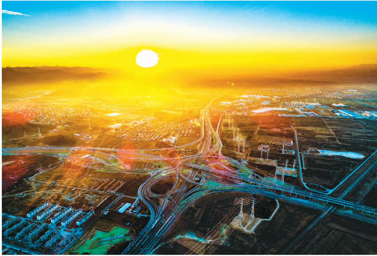
未来，京礼高速兴延段将与延崇段相接合并成京礼高速，形成北京西北方向第三高速通道，作为京津冀一体化路网格局的重要组成部分。图为夕阳映照下的京礼高速公路兴延段与京藏高速公路交汇的管城子互通立交。
