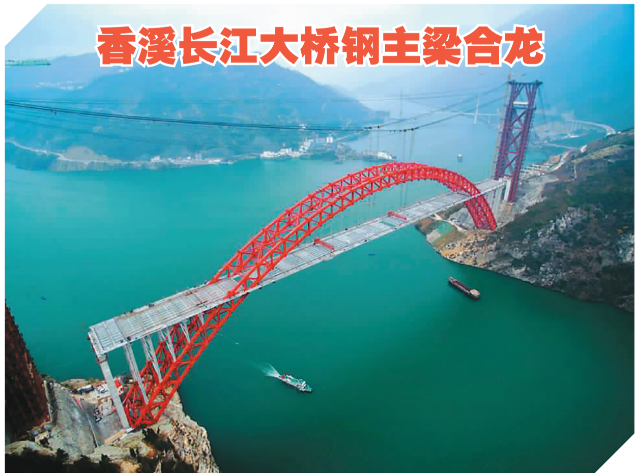
12月27日上午9时58分, 位于湖北省秭归县的香溪长江大桥最后一跨钢主梁成功合龙, 为全桥贯通打下坚实的基础。湖北香溪长江公路大桥项目全长5.419公里, 主要包括香溪长江大桥、香溪河大桥、灵观台大桥、吴家沟隧道等, 是一个由多座特大型桥梁、隧道组成的项目群, 将于2019年10月全线竣工。 图为钢主梁合龙现场全景。 雷勇摄(人民视觉)
