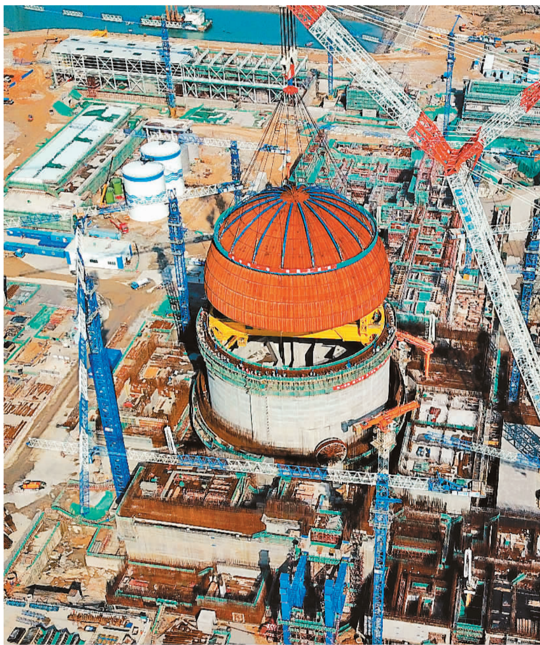
3月21日，国内第二台“华龙一号”（中核集团福清核电6号机组）完成反应堆穹顶吊装。 新华社记者 魏培全摄
