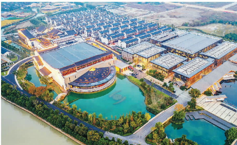
航拍乌镇互联网国际会展中心
