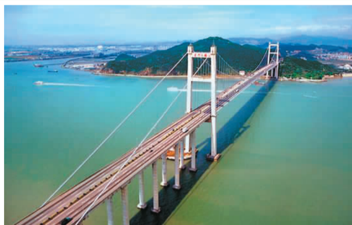
▲ 1997年建成的广东虎门大桥，被誉为中国的“第一跨”。如果将两根主缆的钢丝拉成一条钢绳，足可绕地球一圈。 图片来源：人民网
