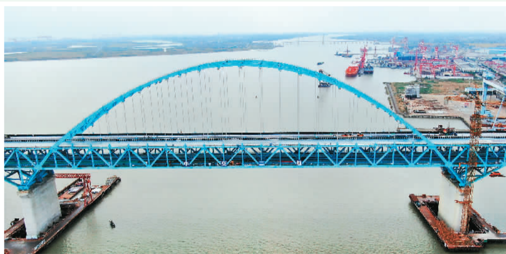
▲ 沪通长江大桥是目前世界上最大跨度的公铁两用斜拉桥。大桥于2014年3月1日开工建设，计划工期5年半。因为10月21日，沪通长江大桥天生港航道桥桥面环氧沥青正式摊铺。 许丛军摄（人民视觉）
