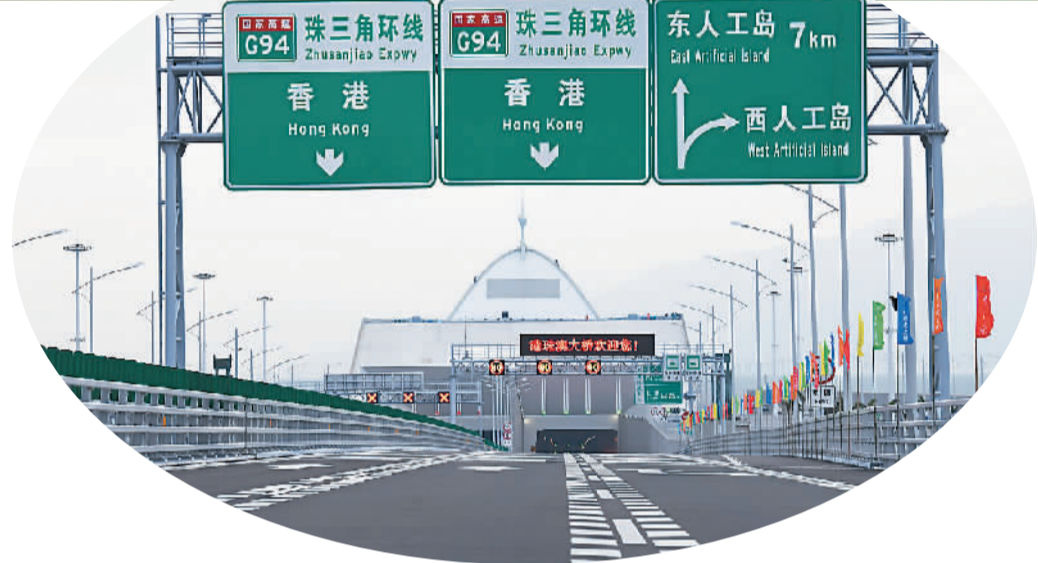
港珠澳大桥西人工岛隧道口。
