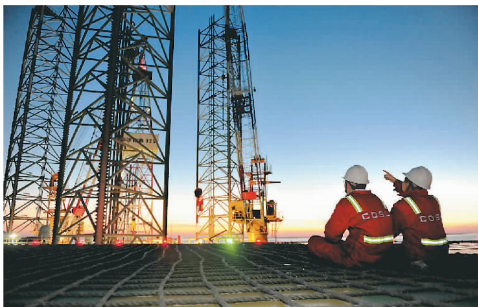
图为中国海洋石油921钻井船在进行钻井作业。 李佑坤摄
