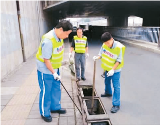
北京排水集团第二管网分公司养护二班，汛期前 检查雨水口。 葛林摄
