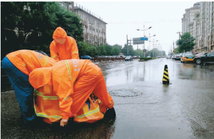
大鲁店北路防止污水井顶拖提前安装防汛筒，做好准备 刘泽伟摄
