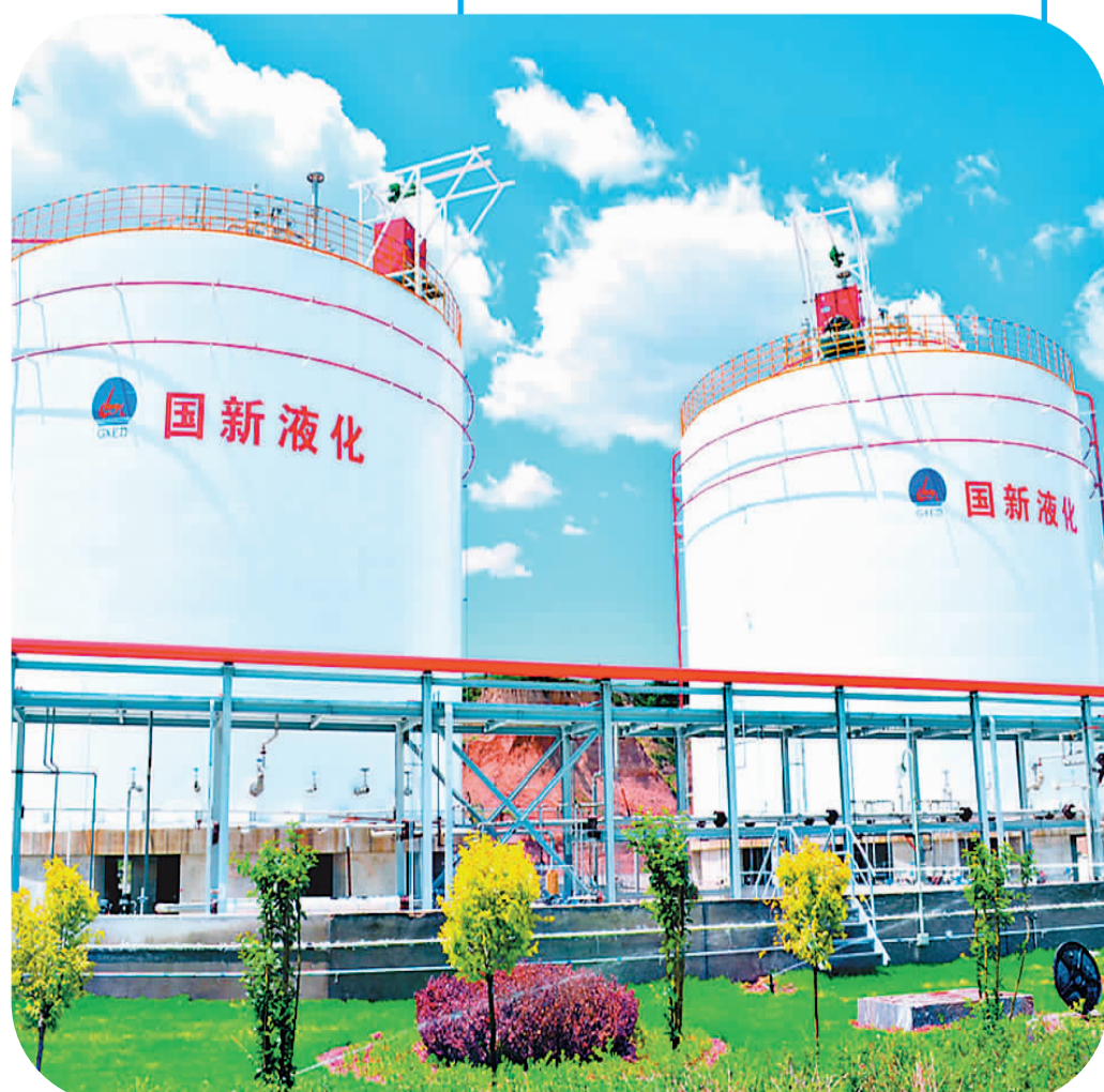
山西国新能源寿阳县煤层气天然气综合利用示范园区 来自百度
