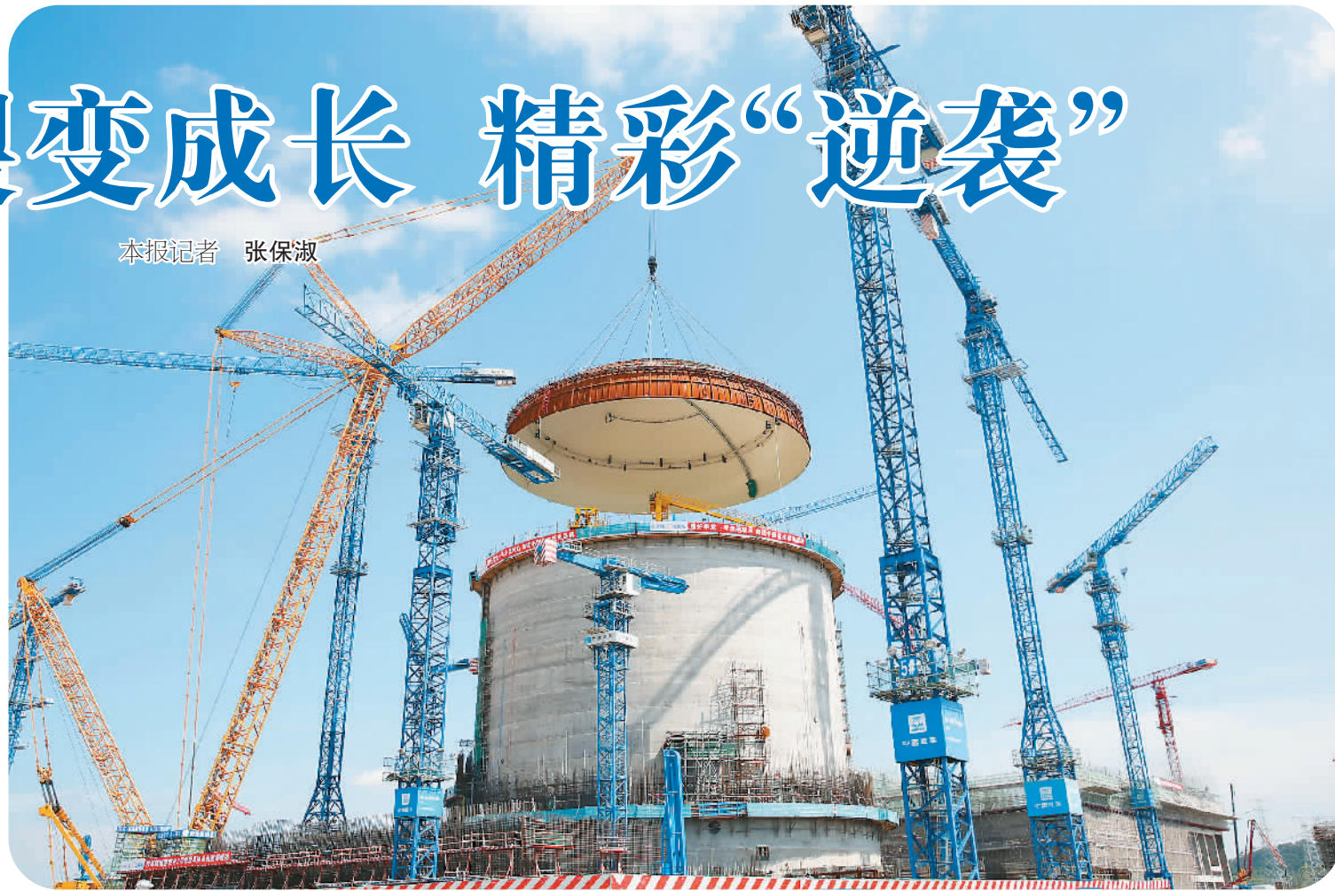
广西防城港核电3号机组是中国第三代核电技术品牌“华龙一号”的示范工程。图为该机组穹顶吊装现场。
