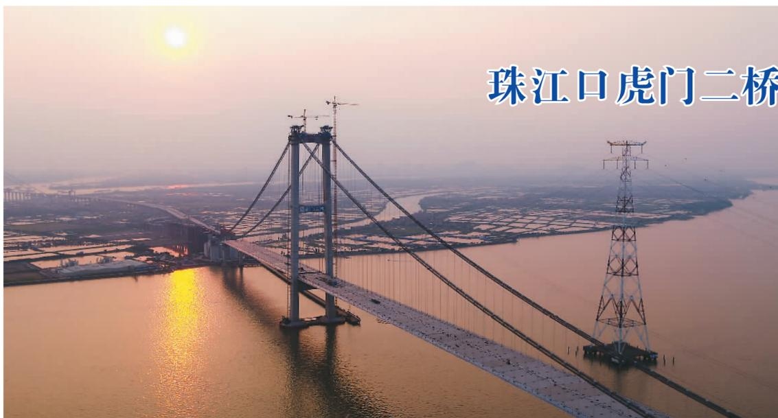
“粤港澳大湾区”重要交通基础设施项目——虎门二桥取得重大建设进展，作为虎门二桥的一座主桥，跨径1688米的坭洲水道桥近日顺利合龙。
