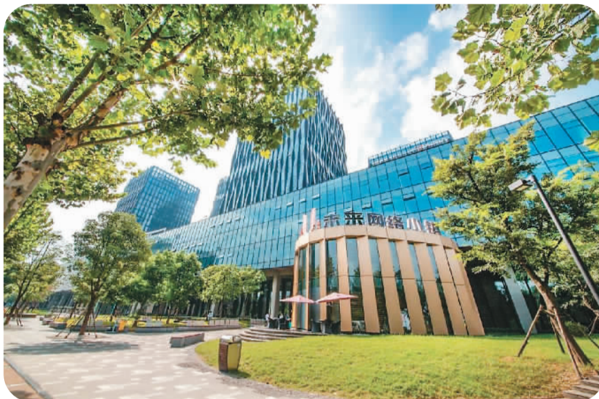
南京“未来网络”小镇内建筑实景图
