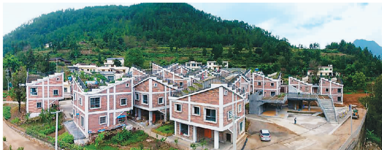
四川省巴中市南江县金台村的新型房屋。
