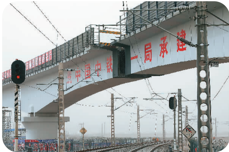
5月8日上午，经过110分钟的转体施工，中国高海拔地区首座转体梁桥——格库铁路格东特大桥转体梁桥顺利合龙，标志着转体梁工程首次在青藏高原转体成功。 新华社记者 韩方方摄
