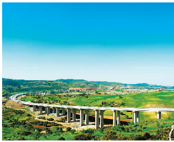
阿尔及利亚南北高速公路希法段项目由中国建筑股份有限公司阿尔及利亚分公司修建。图为工程机械在进行桥梁铺设。新华社发
