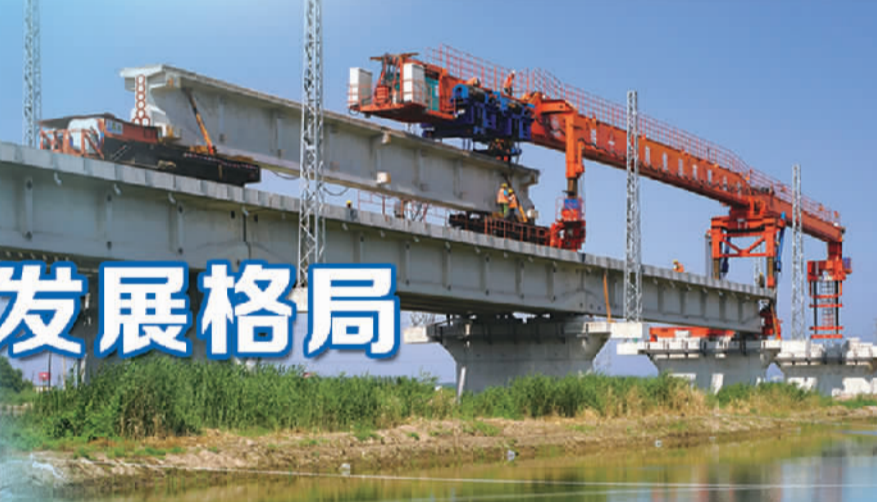
正在建设中的唐曹铁路
