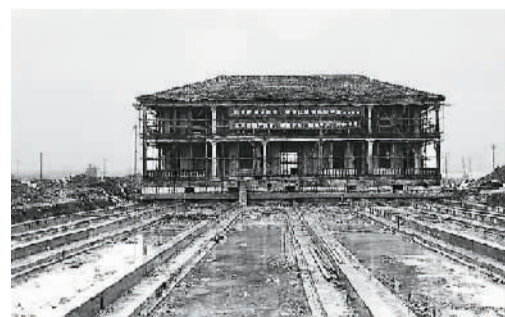
图为正在施工中的王文翰故居。 龚子皓摄
