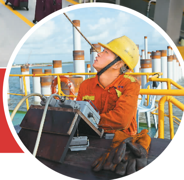
7月30日，在肯尼亚拉穆港，工作人员在中国交建“粤工班11号”施工船上工作。新华社记者 陈诚摄
