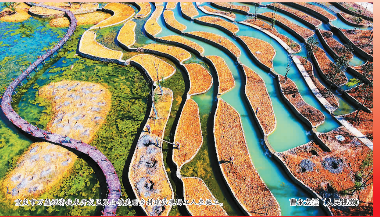
重庆市万盛经济技术开发区黑山镇美丽乡村建设现场工人在施工。曹余龙摄（人民视觉）
