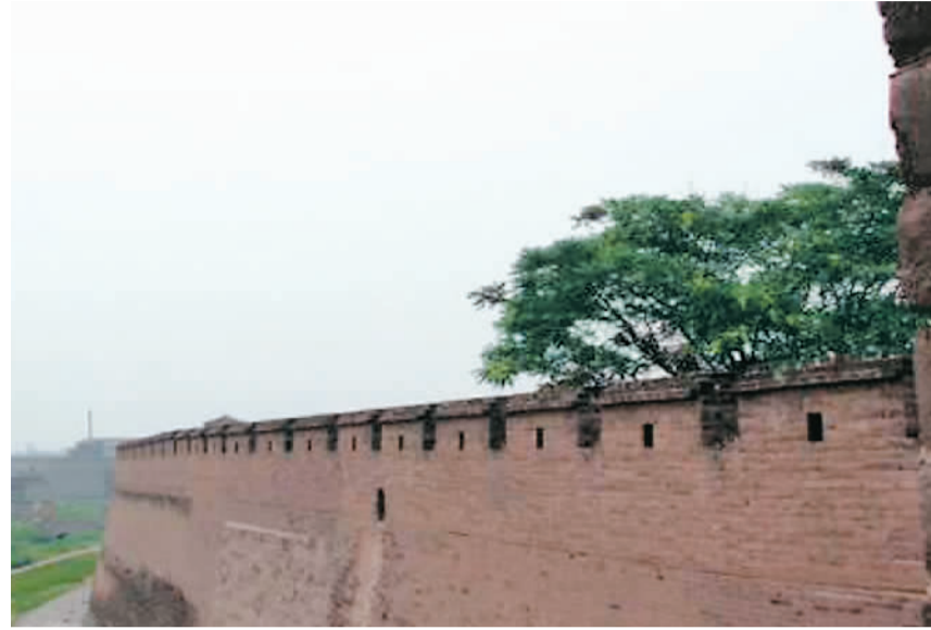
汾州重新修葺的城墙
