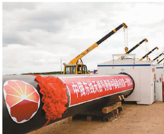
图为中俄东线天然气管道中国境内段在黑龙江省黑河市开工建设（2015年6月29日摄）。新华社发
