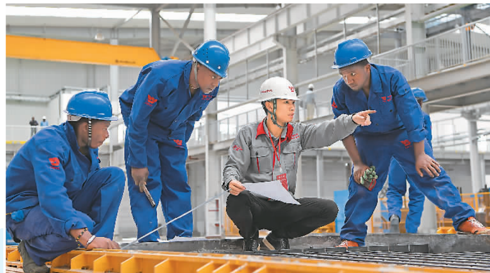
图为在东非国家肯尼亚，一家中国企业正运用装配式建筑技术帮助该国逐步推进建筑工业化进程。 新华社记者 陈诚摄
