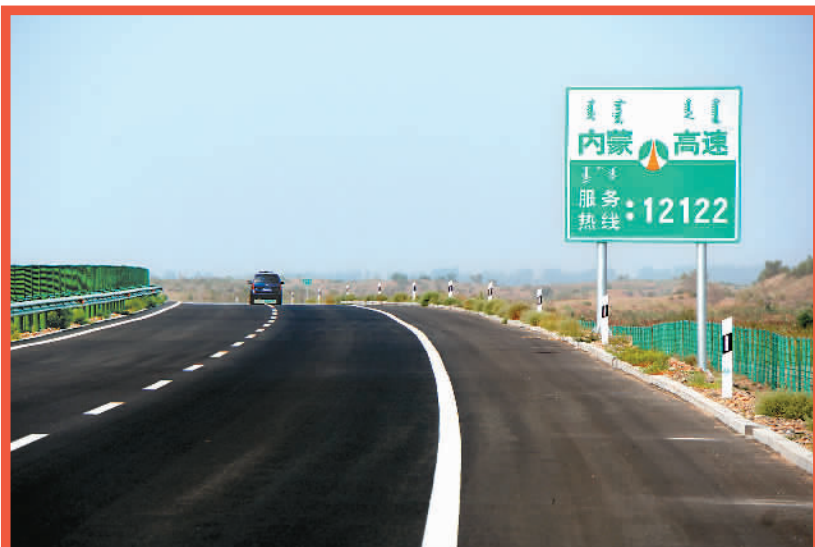
▲ 京新高速内蒙古段实景。京新高速的贯通，使得北京到乌鲁木齐的公路里程缩短近1300公里。
