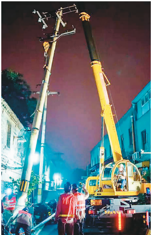
图为工作人员在大栅栏商业区樱桃斜街的胡同深处拆除电线杆。
