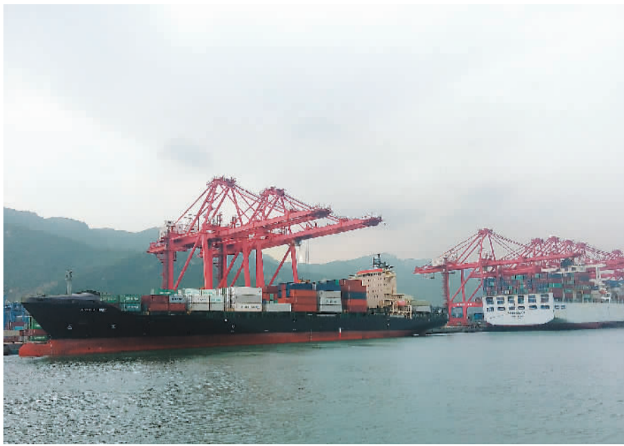
图为连云港庙岭作业区码头，港口起重机正在为货轮装卸货物。
