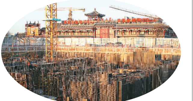
2016年12月2日，正在修缮中的北京中轴线前门地区文化老街。 郭俊峰摄(人民视觉)
