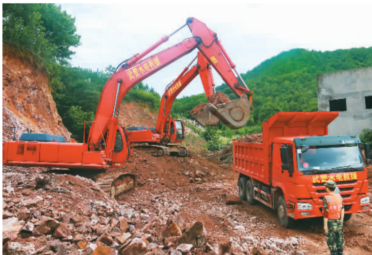
▲ 7月1日，受长江上游连续强降雨影响，长江安徽段水位不断上涨，巨大的压差对安徽枞阳县枞阳闸安全造成严重威胁。驻皖武警水电部队第一时间启动应急预案，紧急抽组85名兵力、35台套大型主战装备，火速赶赴现场。图为挖掘机在高坡选取土石料运往堤坝处。 马帅伟 田端磊摄影报道
