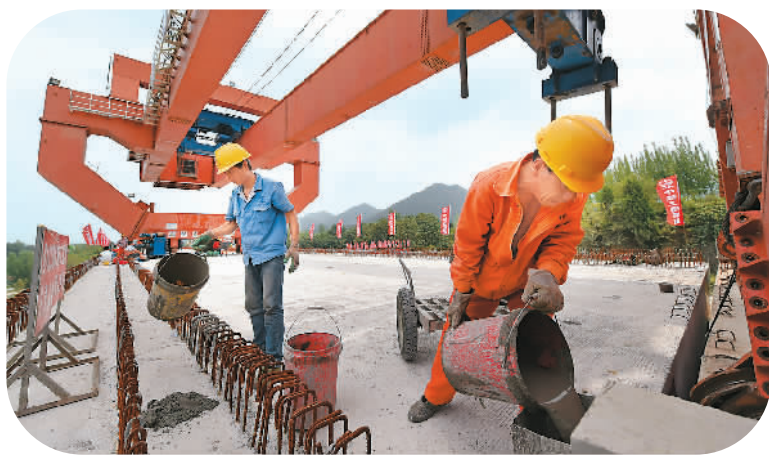
7月21日,济青高铁从济南新东站到胶州北站时速350公里的高速段架梁工程竣工,全面进入无砟轨道施工阶段。济青高铁预计2018年建成通车,届时将实现济南到青岛1小时到达。
