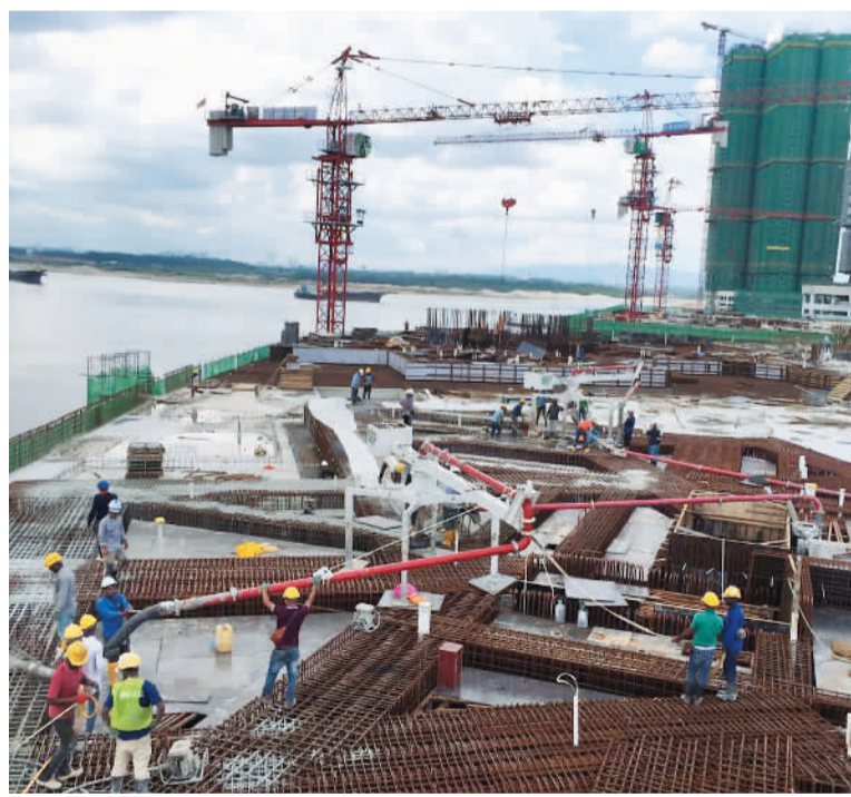
陕建华山国际集团承建的碧桂园马来西亚金海湾项目施工现场
