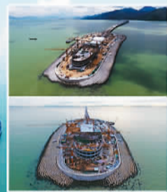
大桥主体工程的人工岛
