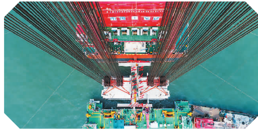
大桥岛隧工程海底隧道的最终接头——重约6000吨的钢结构混凝土预制件在伶仃洋主航道吊装下沉对接完成。李建束摄
