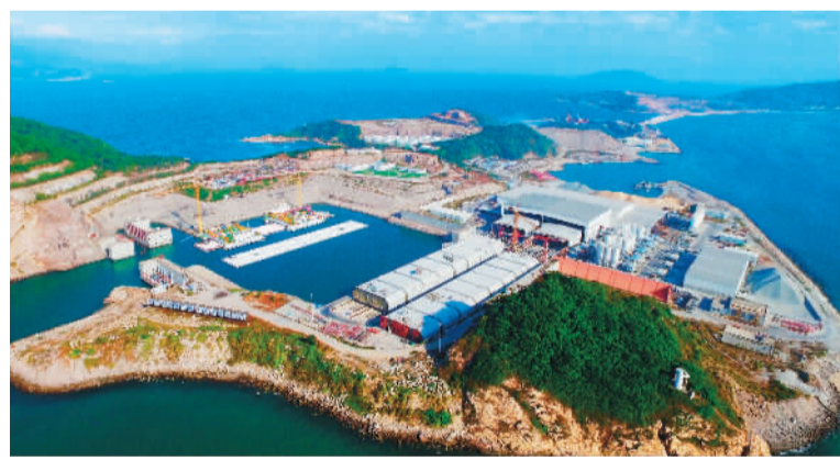
大桥建设者在海外荒岛建成了世界最大的沉管预制厂，并创下了浇筑百万方混凝土无一裂缝的奇迹。黄育波摄
