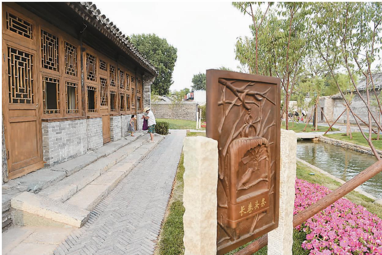
图为刚建成的北京市东城区三里河绿化景观项目。
