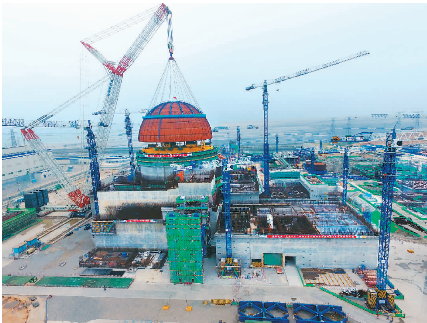
5月25日,“华龙一号”核电站全球首堆示范工程福建福清核电5号机组完成穹顶吊装,标志着该工程全面转入设备安装阶段。“华龙一号”是我国自主创新、拥有完整自主知识产权的三代核电技术。2015年5月7日,“华龙一号”全球首堆示范工程在福建省福清市开工建设。图为福清核电5号机组在进行穹顶吊装。新华社记者 姜克红摄
