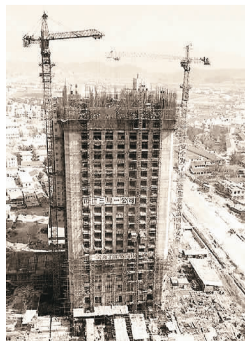
正在建设中的深圳国贸大厦。
