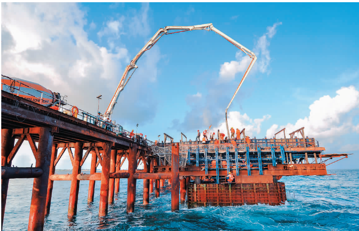
作为“21世纪海上丝绸之路”的重点项目，马尔代夫中马友谊大桥连接首都马累和机场岛，使天堑变通途。图为建设中的中马友谊大桥。
