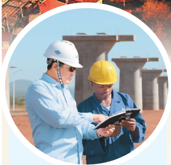
中方员工在蒙内铁路建设现场培训当地员工
