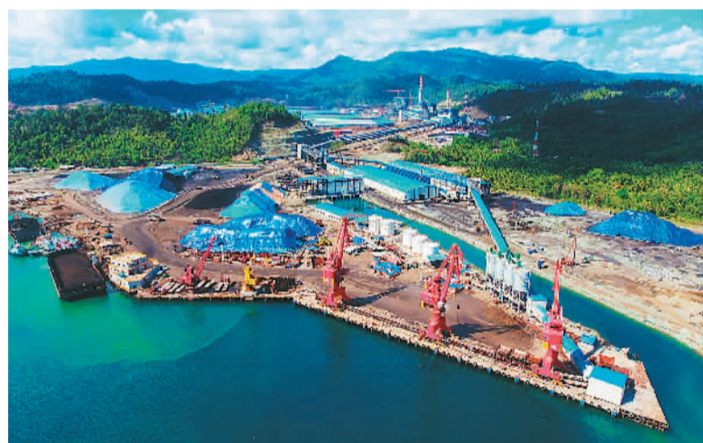
设。图为在印尼中苏拉威西省拍摄的青山工业园自备码头。 杜宇摄(新华社发)
