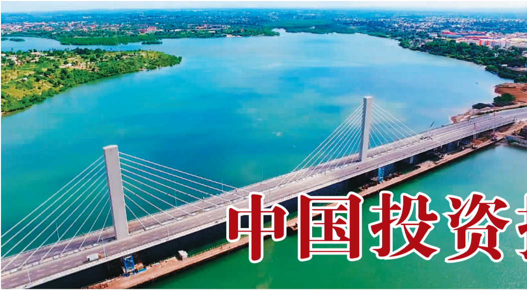
2016年4月,由中国公司承建的东非最大斜拉式跨海大桥尼雷尔大桥通车。 新华社发
