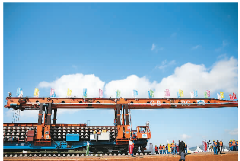
建设。蒙内铁路是肯尼亚独立以来的最大基础设施项目,由中国路桥公司承建,为当地创造了大量就业岗位。 潘思危摄(新华社发)
