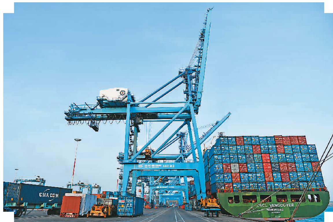
肯尼亚蒙巴萨港是东非第一大港，在东非地区占有重要地位。图为由中国路桥公司承建的肯尼亚蒙巴萨港第19号泊位。 孙瑞博摄（新华社发）
