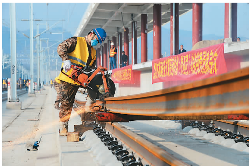
2月28日上午9时,西成高铁宁强南站站内最后一根钢轨铺设完毕,标志着中国首条穿越秦岭的高速铁路——西成高铁陕西段正线、站线轨道全线铺通,为西成高铁全线按期开通运营奠定了坚实基础。图为施工人员在西成高铁宁强南站进行最后一根钢轨铺设作业。
