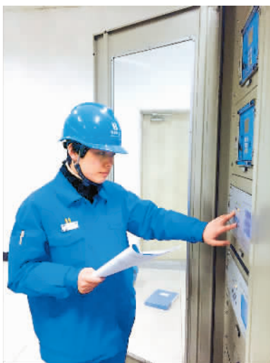
冯相明在华能淄博白杨河发电有限公司的日常工作中，是给设备输入保护定值。
