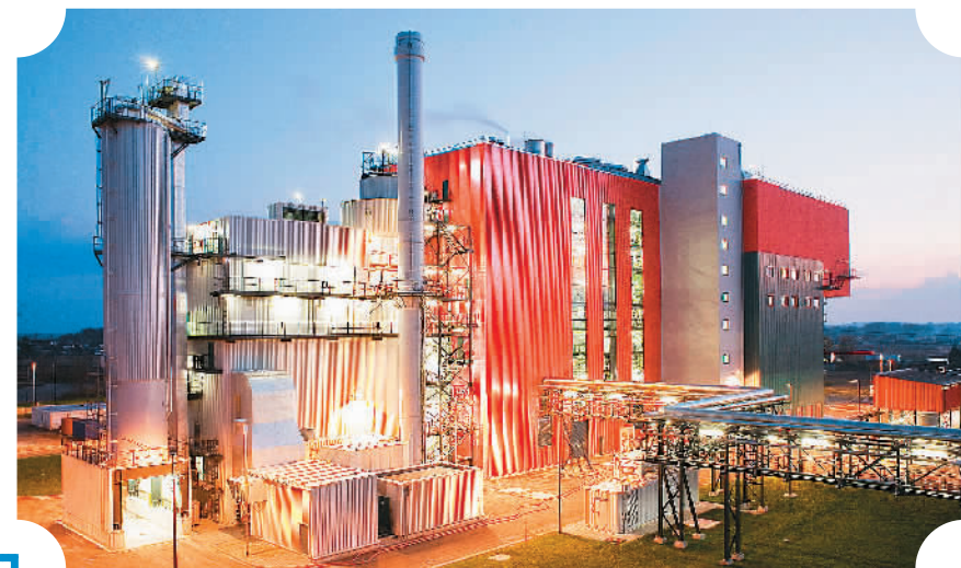
图为欧洲能源利用(EEW)公司厂区
