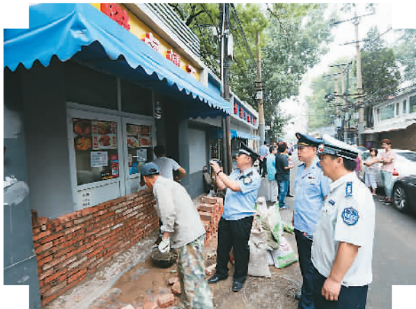
图为2016年,北京市东城区整治胡同内拆墙打洞及无照无证经营的店铺。(人民视线)
