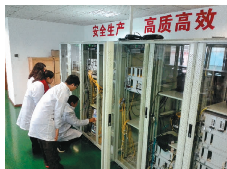
技术人员在调试设备
