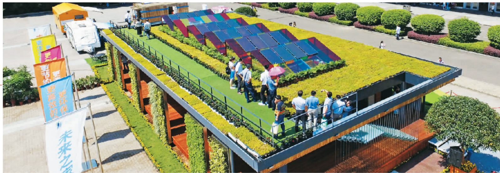
重庆市民在该市展览中心参观（L205）绿色之家”建筑。太阳能光热、雨水收集系统于一身。（新华社记者 陈诚摄）
