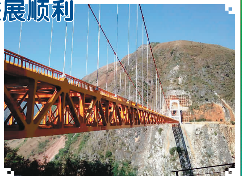
图为中缅油气管道澜沧江跨越工程
